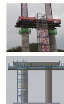
盖梁系梁施工平台
